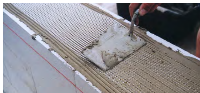
Armierung mit Armyt-Glasfasergewebe
