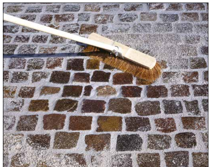
6 Säubern des verfugten Belags.
