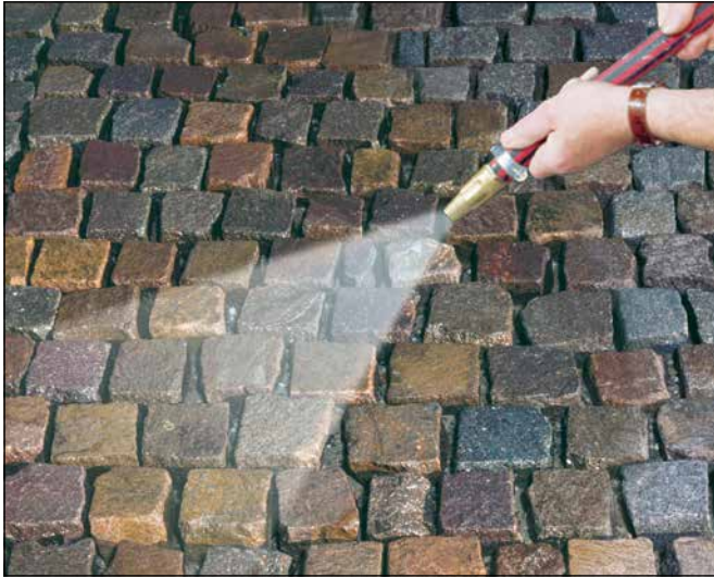
1 Vornässen des gereinigten, zu verfugenden Belags.
