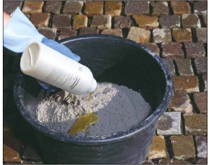
2 Härterzugabe und Anrühren von Sopro EpoxiPflasterFuge 2-K.
