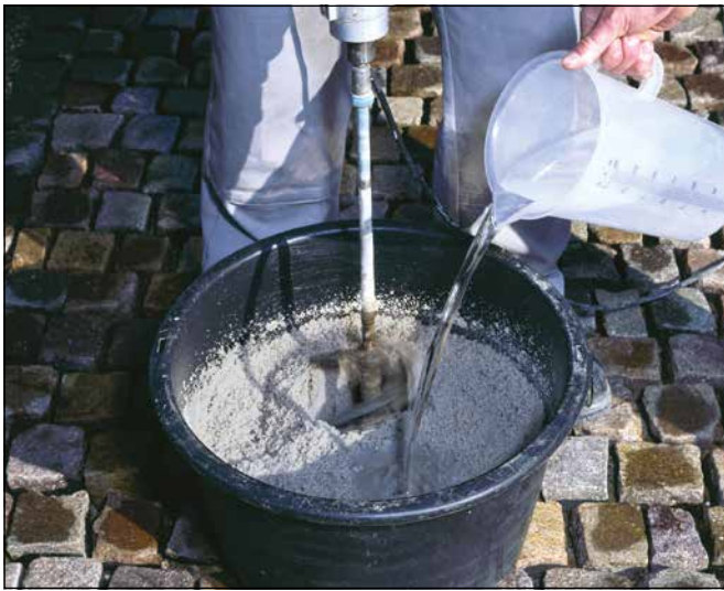
3 Nach dem Anrühren von Sopro EpoxiPflasterFuge 2-K ca. 2l Wasser zugeben und erneut anrühren.
